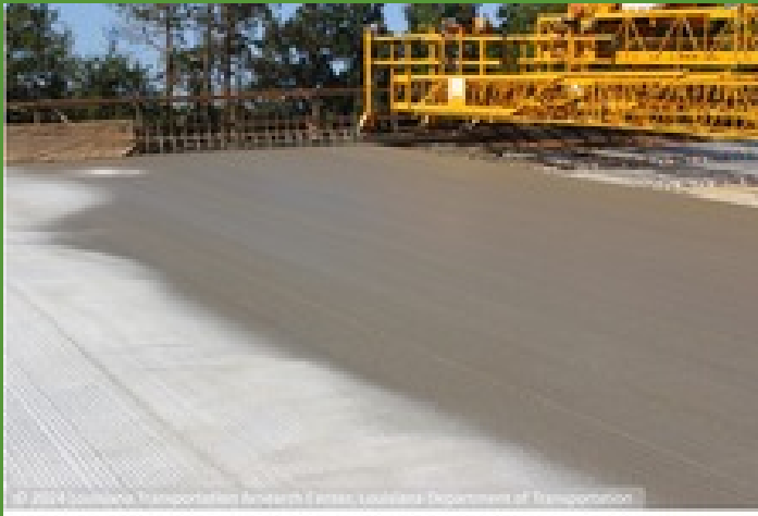
Figura 3. Tablero de puente curado internamente colocado en Louisiana. Fuente: LTRC y LDOT
