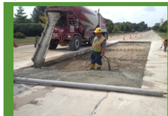
Figura 1. Hormigón curado internamente utilizado para el parchado de pavimentos de hormigón Fuente: CP Tech Center
