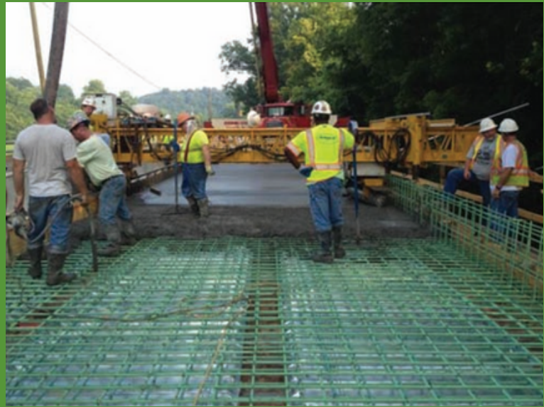
Figura 2. Tablero de puente curado internamente siendo colocado en 2013 en la US 150 sobre Lost River en Orange County, Indiana. Fuente: Barrett, T. J., Miller, A. E., & Weiss, W. J. (2015).
