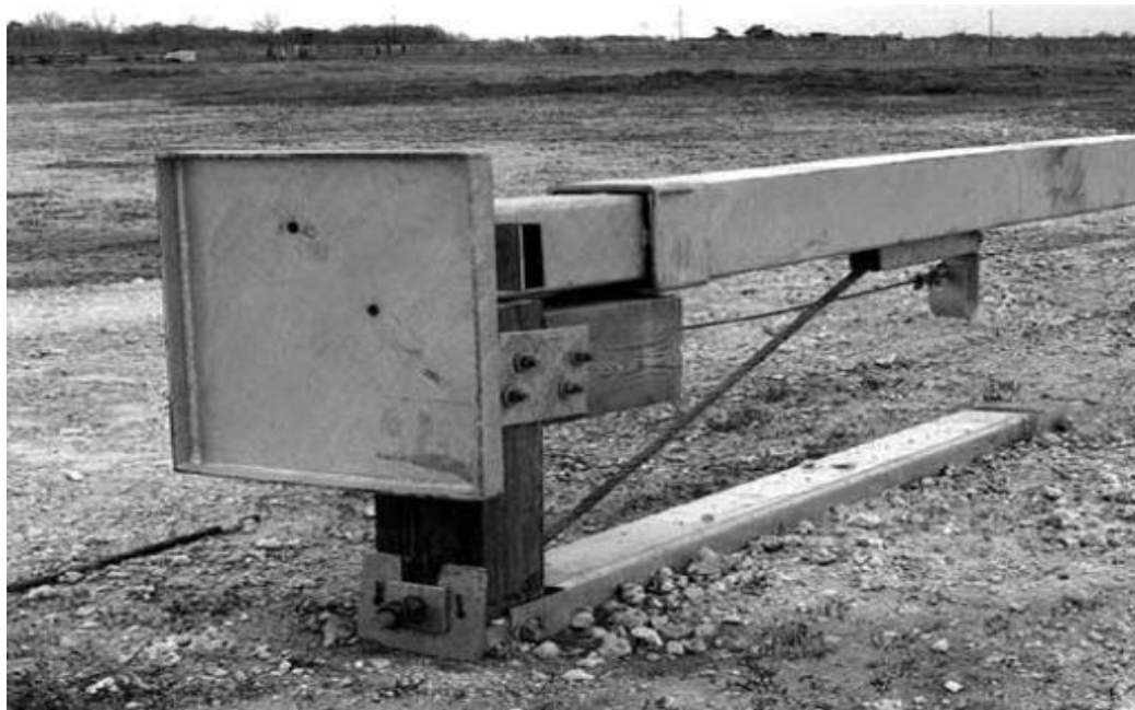
Wyoming Box-Beam End Terminal (WY-BET™)
