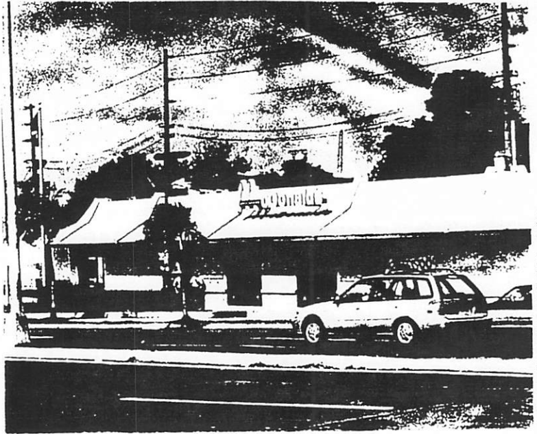
El tradicional McDonald's de la Roosevelt va rumbo a la demolición a causa del planeado desarrollo de la estación del Tren Urbano en aquella zona de Hato Rey.
