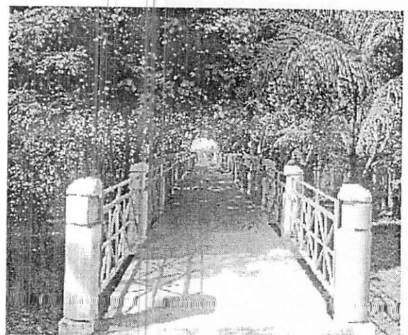
Figura 6 Comienzo del puente
