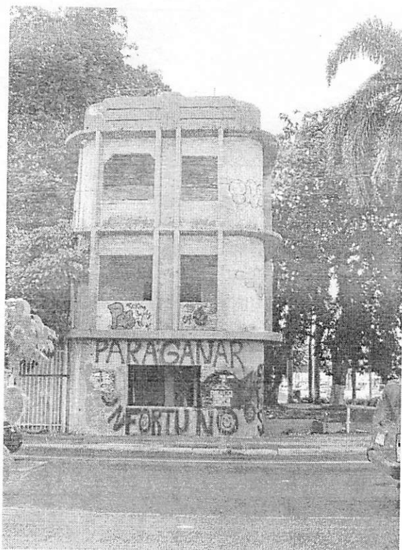
(1.2) Edificio abandonado cerca de la Estación Roosevelt. Ave. Roosevelt, 2007 (Foto por Onix F. Concepción)
