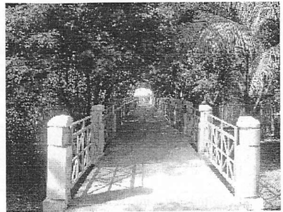
Figura 3.4 Puente en el Paseo Martín Peña Fase I
